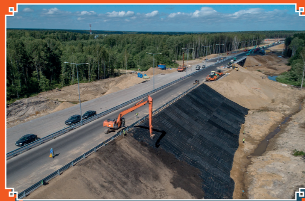
Строительство скоростной автомобильной дороги Москва-Санкт-Петербург на участке 15-й км - 58-й км
