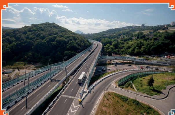
Строительство центральной автомагистрали г. Сочи «Дублер курортного проспекта» от 172 км федеральной дороги М-27 Джубга-Сочи
